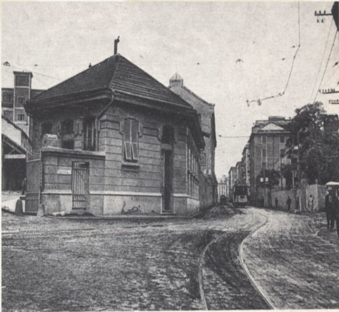
LA PORTINERIA D'ACCESSO AI «MOLINI CERTOSA», CREATI NEL PRIMO DECENNIO DEL '900, CON SULLO SFONDO L'ALTO FABBRICATO DEI «DOCKS INTERNAZIONALI».
