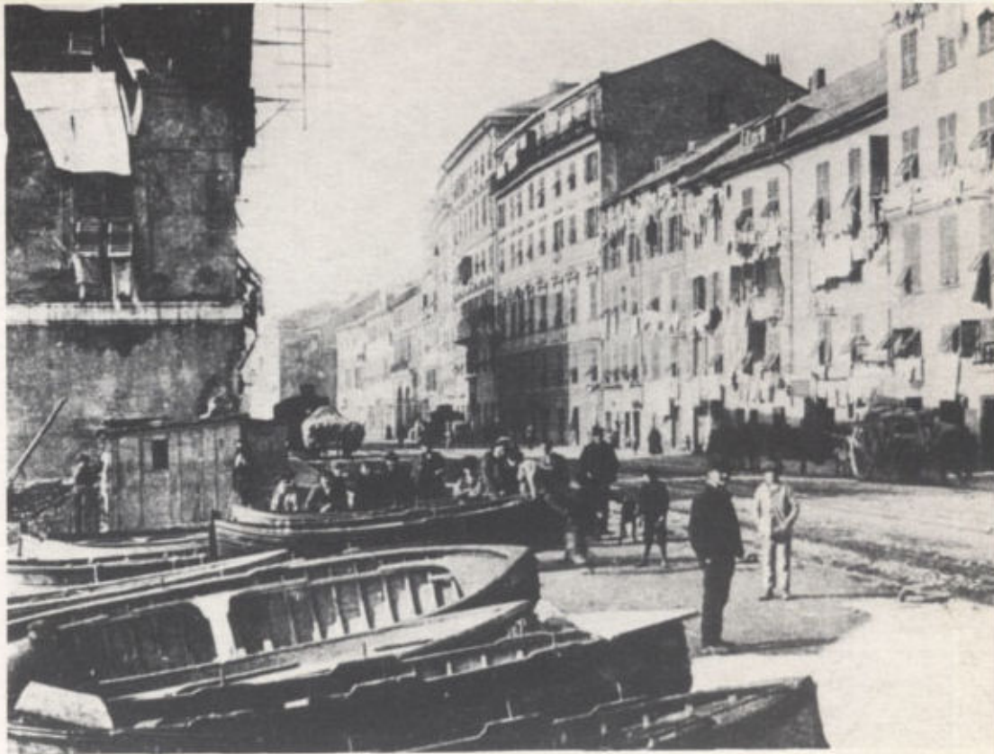
VIA C. COLOMBO A SAMPIERDARENA. NOTARE LE BARCHE TIRATE A SECCO SULLA STRADA A CAUSA DEL MARE GROSSO.
